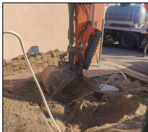
Ci-dessus: enlèvement de la cuve enterrée du bâtiment scolaire près de la cantine.
